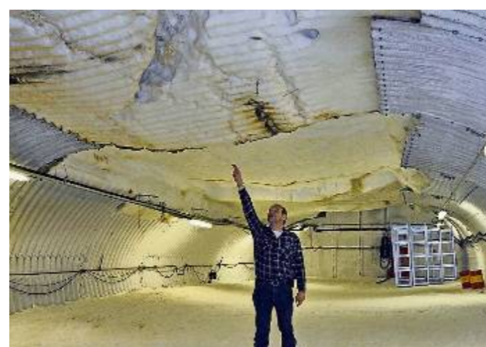
20 Meter Schnee liegen über den Röhren von „Neumayer II“. Die 1993 gebaute Station versank im Laufe der Jahre immer mehr im Schnee. Durch Eisdrift und Schneelast wurde der Röhren-Bau deformiert. Ein Ersatz musste her. Im Jahr 2010 wurde „Neumayer II“ bis auf die Röhren abgebaut. Einige Container wurden von den Südafrikanern übernommen. Foto: Wöste/AWI
