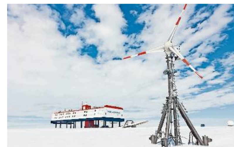
380 302 kWh Energie hat das Windrad an der Neumayer-Station in den vergangenen zehn Jahren erzeugt. Die Forschungsbasis hat ein ausgeklügeltes Versorgungskonzept mit moderner Technologie. Das Leben in der schützenden Hülle wird erst durch ein Blockheizkraftwerk mit drei Dieselgeneratoren möglich. Ein weiterer Generator steht zu jeder Zeit als Notstromaggregat zur Verfügung. Foto Steuer/AWI
