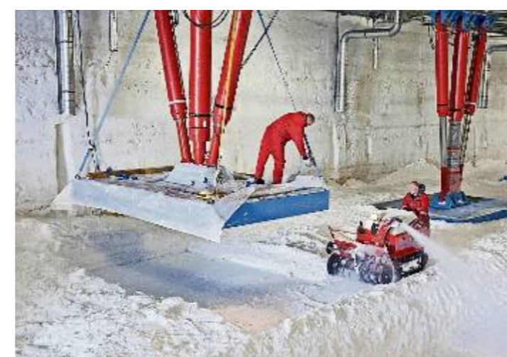
22 Mal wurde die Plattform mit der Station in den vergangenen zehn Jahren angehoben. Das ermöglichen 16 hydraulische Stelzen – der Clou der Station. Sie steht so immer sechs Meter über dem Eis. Der durchschnittliche jährliche Schneezutrag betrug bisher 90 Zentimeter in der Umgebung, an der Station selbst durch Schneeverwehungen wesentlich mehr. Foto: Stelzer/AWI
