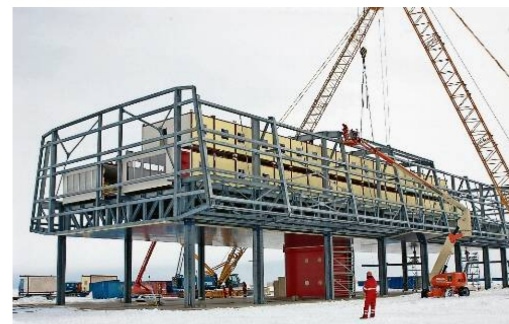
3500 Tonnen Material, Baumaschinen und Ausrüstung wurden per Schiff in die Antarktis transportiert. Die Station „Neumayer III“ ist „made in Bremerhaven“: Den Auftrag bekam das Firmenkonsortium J. H. Kramer Stahlbau und Kaefer Isoliertechnik, die ARGE Neumayer III. Die Station wurde zum Großteil in Bremerhaven gefertigt und teilweise vormontiert. Rund 50 Ingenieure und Techniker arbeiteten auf der eisigen Baustelle. Der Spezialbau kostete samt Projektierung rund 39 Millionen Euro. Foto: Realnature.tv
